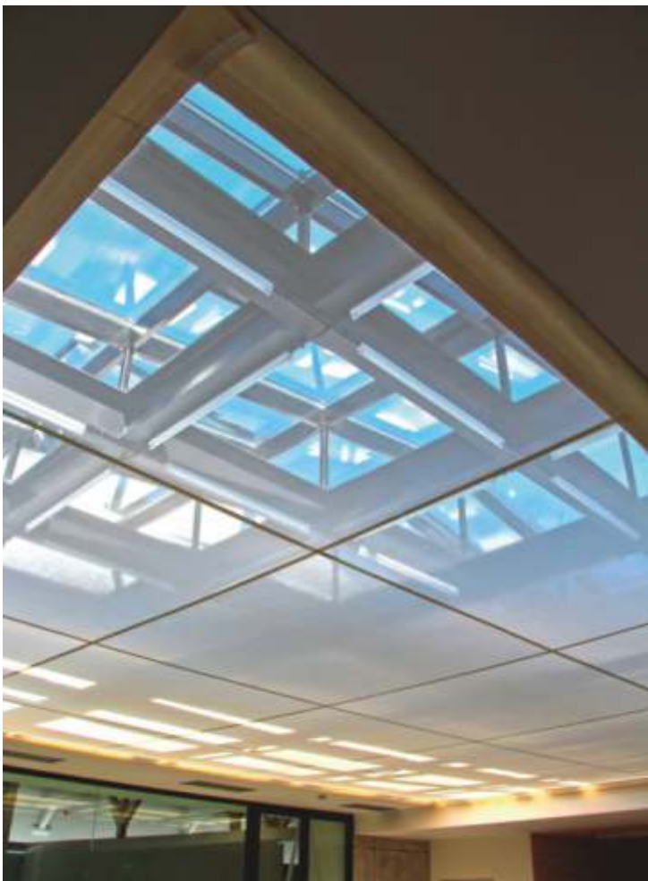
Podhľad z perforovaného materiálu
